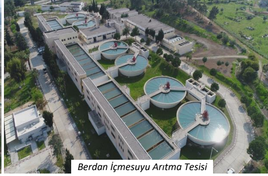
Berdan İçmesuyu Arıtma Tesis
