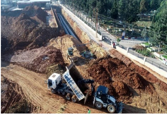
Stabilize Malzemeli Yol Çalışması
